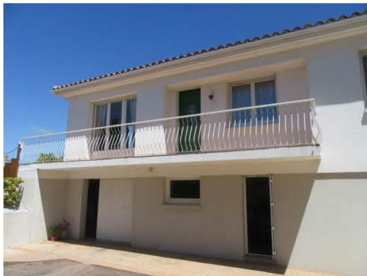
Façade de la maison exposée sud-ouest
